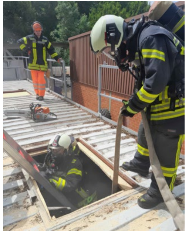
Der Angriffstrupp steigt zur Menschenrettung durch die geschaffene Öffnung ein.
